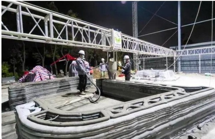
图 11 混凝土增材制造技术建造两座 2.5 米的小型建筑
